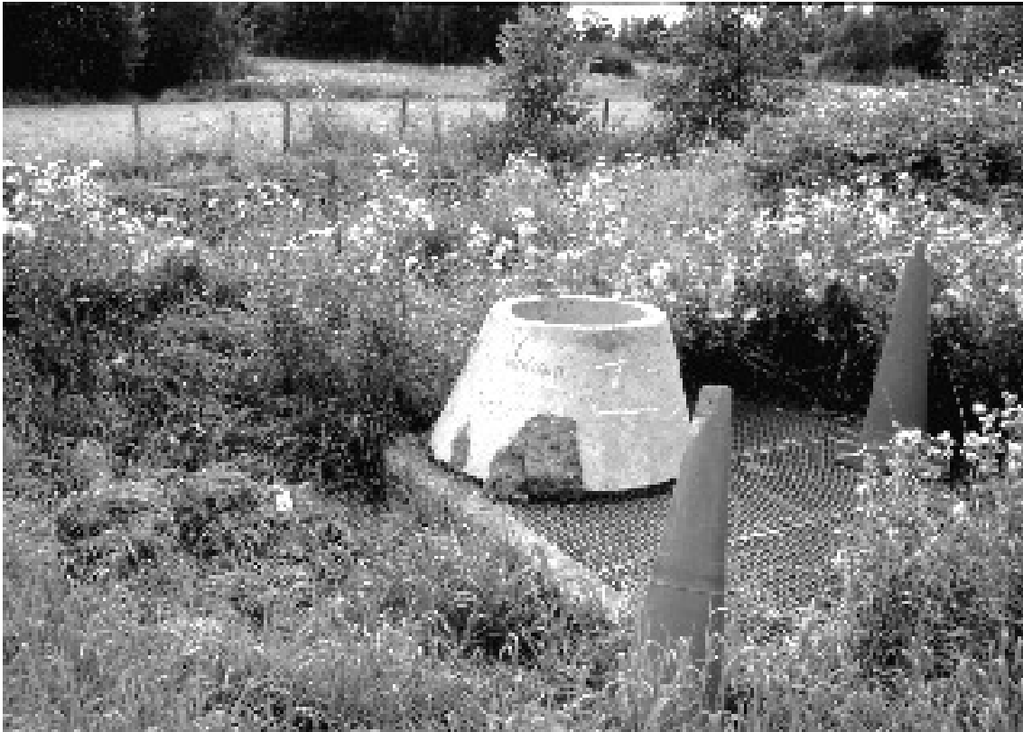
Bild 4. Schaktet ner till dagvattentunneln från Tensta till Järvatunneln ligger alldeles norr om Igelbäcken på delsträcka A14 vid Eggeby.
